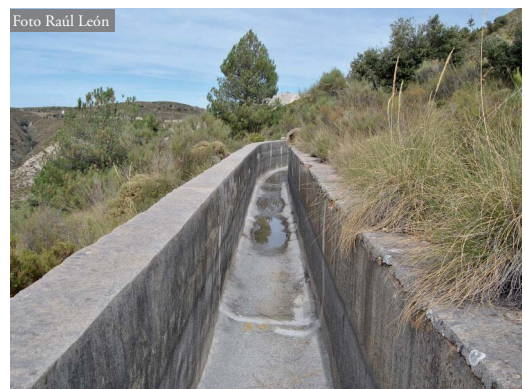
Figura 2: El canal de la Espartera en un tramo abierto.
